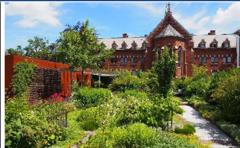
Bild: Dachgarten Diakonissenkrankenhaus Augsburg (Quelle: © Evangelische Diakonissenanstalt)
