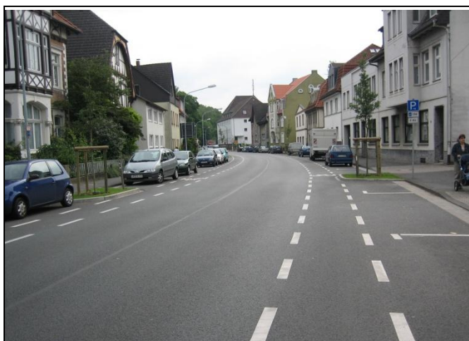
Abb. 5-8: Schutzstreifen mit Sicherheitstrennstreifen zu parkenden Kfz (Lemgo)
