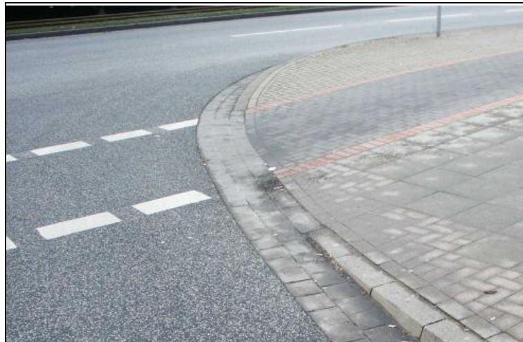
Abb. 5-26: Stoßfreie Radwegabsenkung (Hannover)
