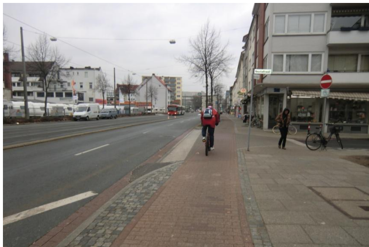
Abb. 5-11: Teilaufpflasterung im Einmündungsbereich einer Nebenstraße (Bremen)
