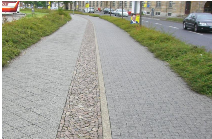
Abb. 5-1: Vom Gehweg getrennter Radweg (Leipzig)
