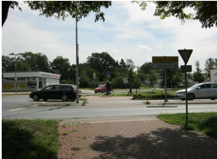
Abb. 5-24: Kreisverkehr Hamburger Straße / Achimer Straße
