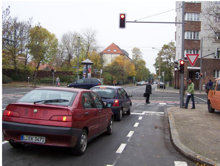
Abb. 5-13: Vorbeifahrtstreifen in einer signalisierten Knotenpunktzufahrt mit zusätzlicher Rotmarkierung (Leipzig, Foto GloBat)
