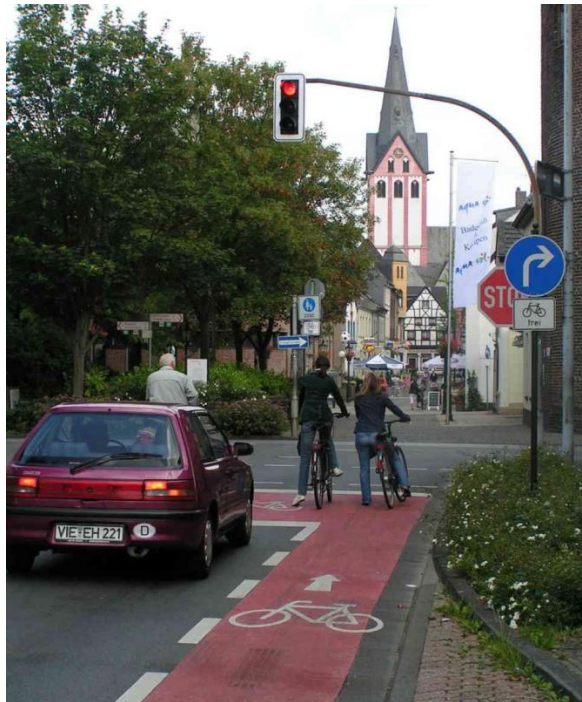
Abb. 5-14: Aufgeweiteter Radaufstellstreifen (ARAS) (Kempen)
