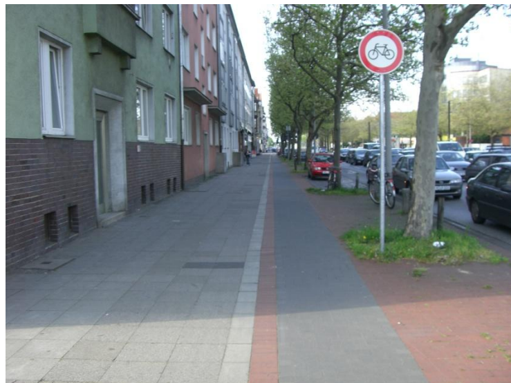
Abb. 5-23: Verdeutlichung des Endes eines Zweirichtungsradweges durch Z 245 StVO (Hannover)
