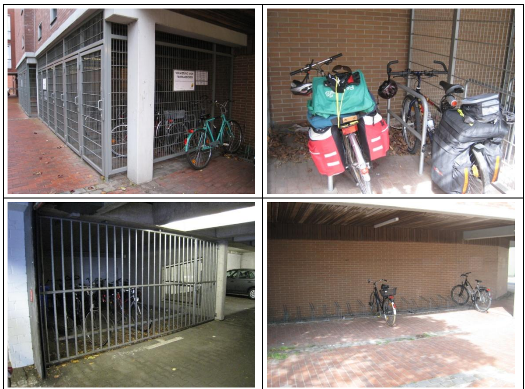
Abb. 6-14: Fahrradabstellanlagen am Parkhaus Südbrücke.
