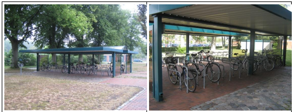
Abb. 6-11: Überdachte Fahrradabstellanlagen am Kreishaus in Verden
