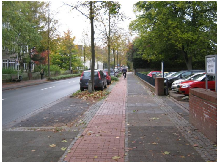
Abb. 5-3: Nicht benutzungspflichtiger baulicher Radweg in Verden (Andreaswall)
