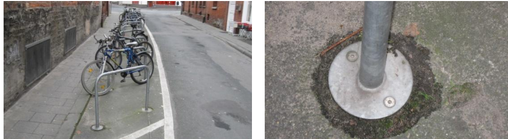
Abb. 6-4: Beispiel für verschraubte Rahmenhalter (Lüneburg)
