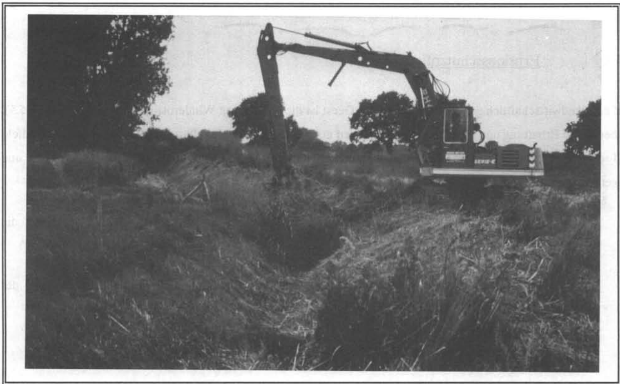
Abb. 21: Grabenräumung im Bereich Dahlhauser Wiesen
